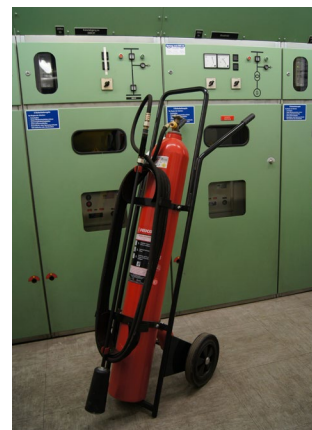
Abb. 45 Fahrbarer Kohlendioxid-Feuerlöscher
