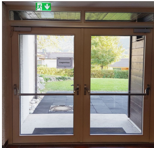
Abb. 18 Notausgang mit Panikstange und Kennzeichnungen
